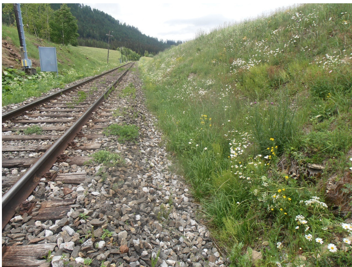
Foto 6 – úsek zárezu v km 88,3 – výskyt pevnejších hornín v päte zárezu vpravo
